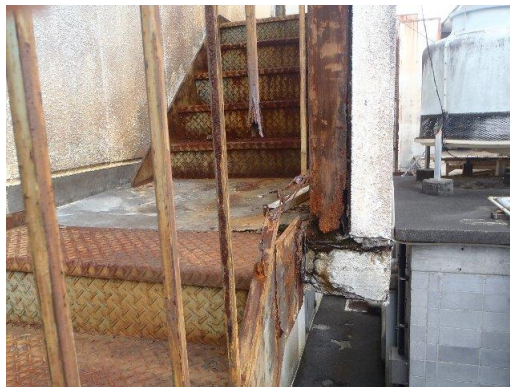
鉄骨の錆による腐食した非常用階段
