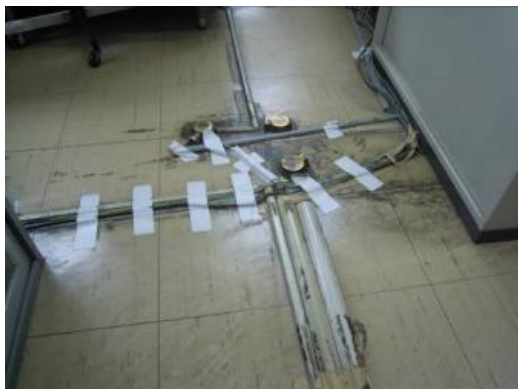
電源ケーブル等敷設状況
