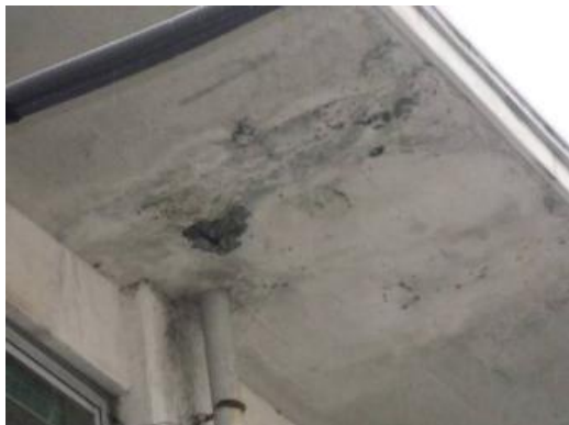
鉄筋の錆によるコンクリートの剥離
