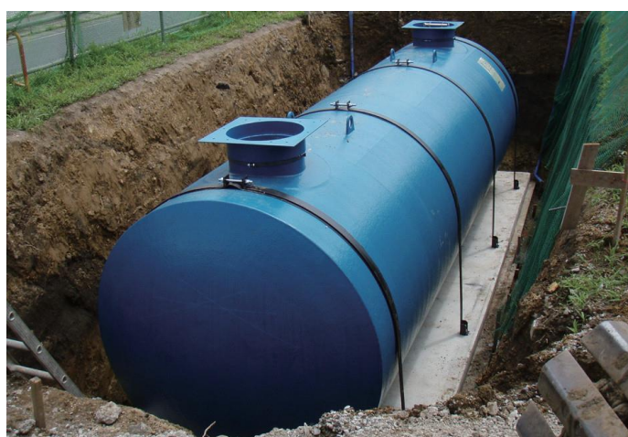
■地下式耐震性貯水槽の例
