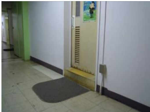
トイレ出入口の開き戸と段差
