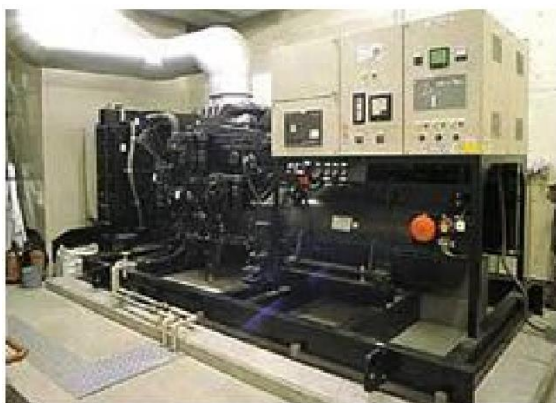
■非常用電源装置の例 出典：(株)東京電機(株)HPより
